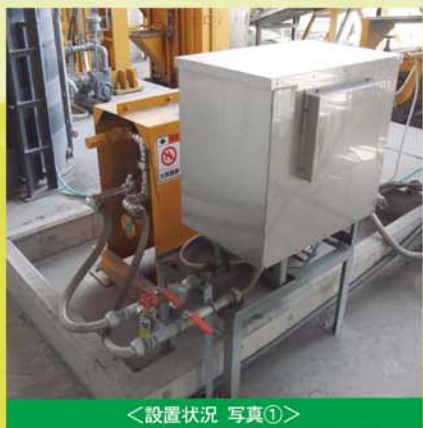
<設置状況 写真①>
